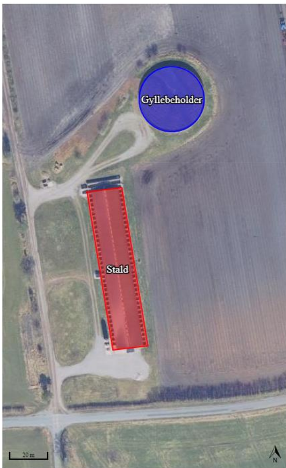
Figur 1: Husdyrbrugets stald og opbevaringsanlæg. Kilde: husdyrgodkendelse.dk
