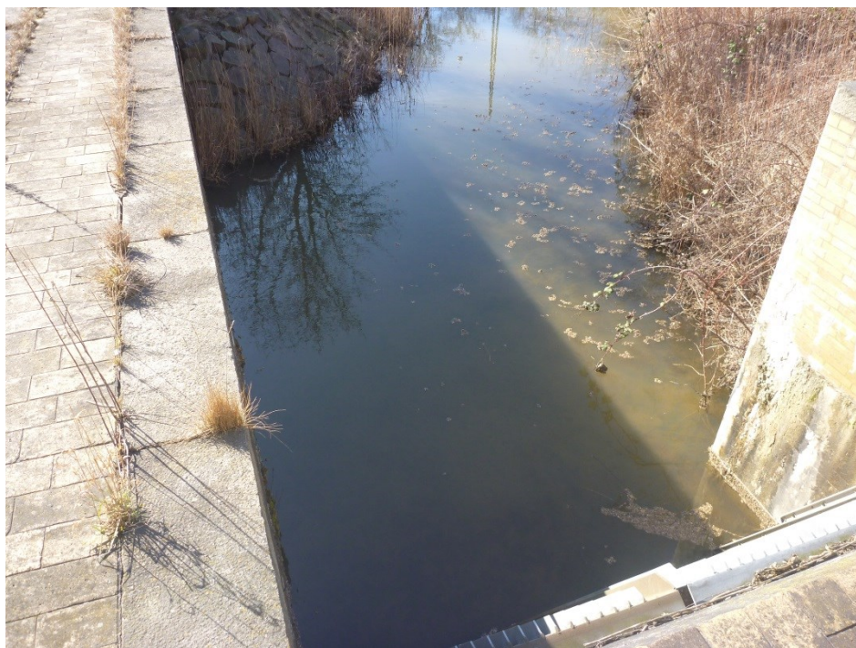
Figur 3. Perkolat fra hovedledningen før udledning til landkanalen. Perkolatet stammer her både fra Jord- og Støjvolde samt Klasse 4 jordsdepotet.
