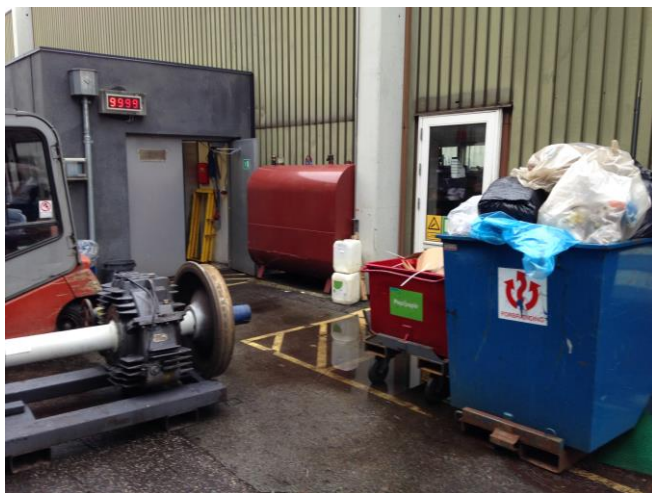
Miljøgård 8: Fyringsolietank til maleværksted.
