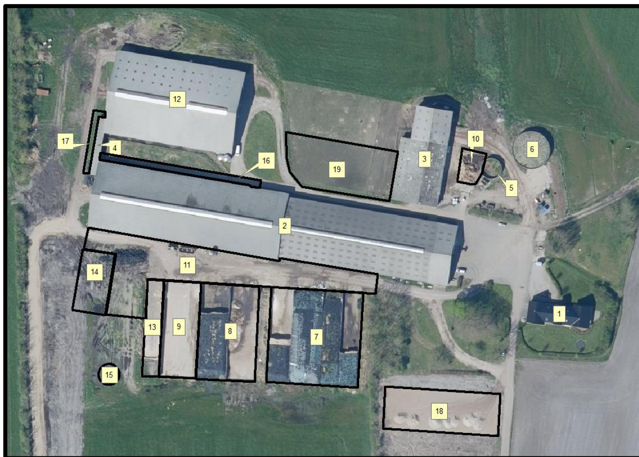
Figur 2. Oversigt over husdyrbrugets bygninger.
