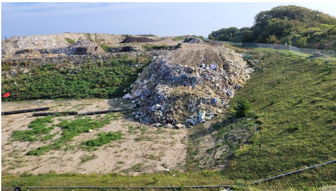
Tømt enhed for forurennet jord, som nu skal opfyldes med blandet affald
