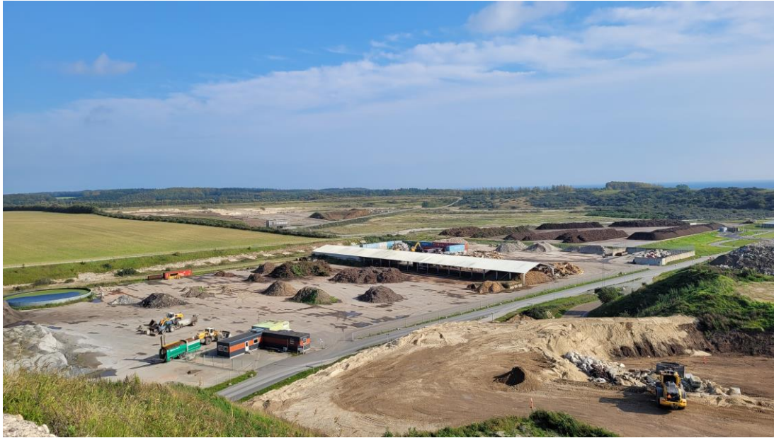
Midt i billedet RGS Nordic, nederst til højre asbestenheden på etape IIa, i baggrunden til højre komposteringspladsen og midt i billedet i baggrunden udgravet jord fra Etape IIa flyttet til Etape IIIa
