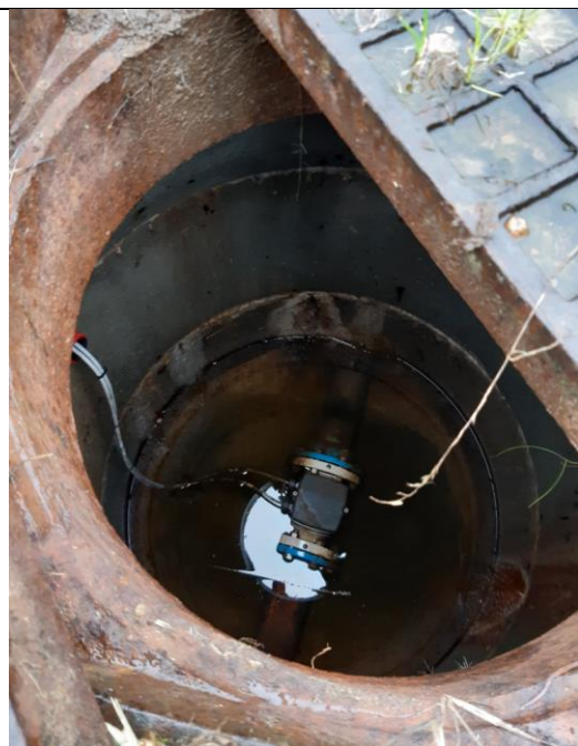
Figur 5. Installation i en af perkolatbrøndene.
