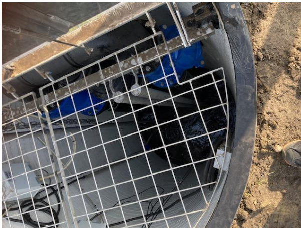
Billede 7: Ny pumpebrønd til erstatning af forsinkelsesbassinet
