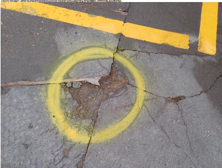
Billede 8: Opmærkning af huller i belægning.
