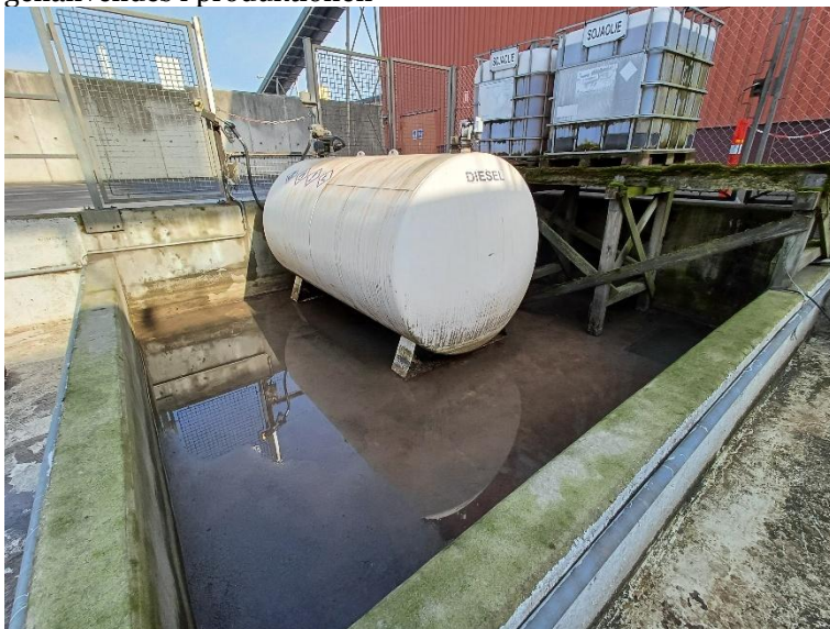
Billede 5: Dieseltank i oliegrav.
