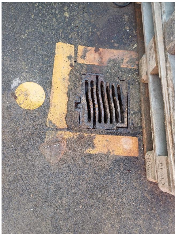
Billede 3: Afløb ved containere til forsøg. Den gule markering indikerer, at vand til afløbet opsamles og genbruges til produktionen.
