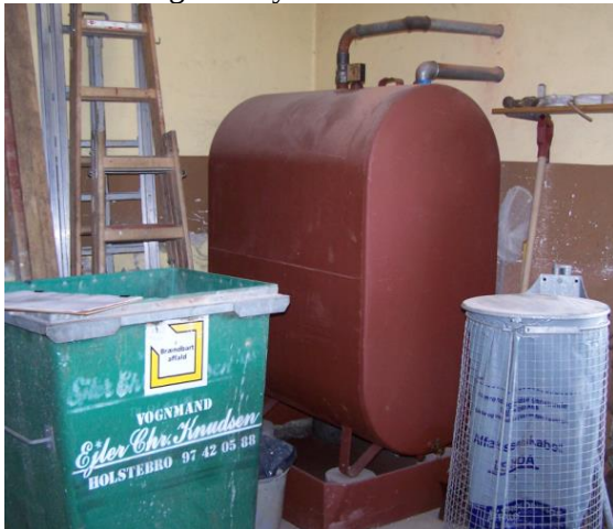
Olietank opbevares i mindre spildbakke
