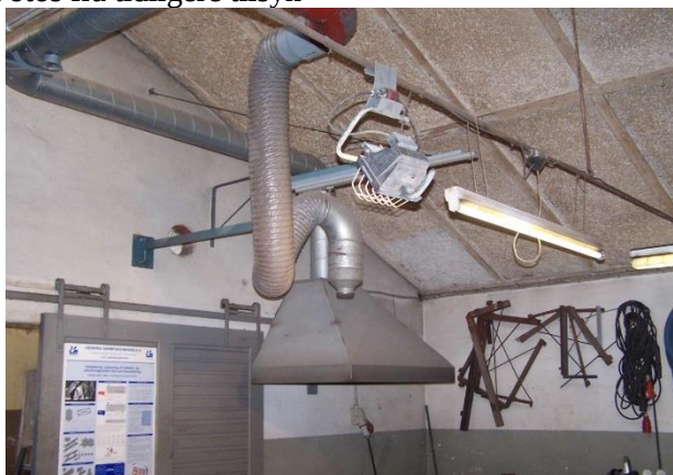
Udsugning fra svejserrøg og røg fra brug af esse
