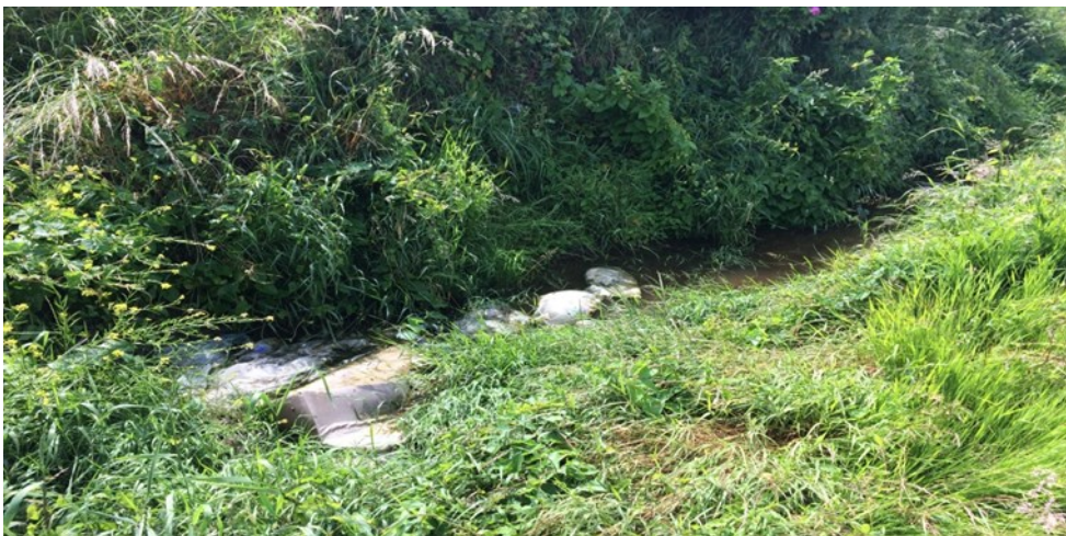
Etableret grøft for opsamling af perkolat
