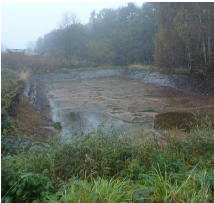
Foto 4: Perkolatbassinet er ryddet for vegetation for at sikre mest mulig plads til evt. perkolat ved tilstopning og fare for overløb.
