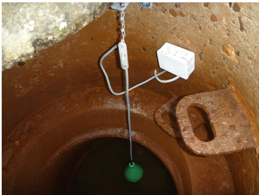
Foto 2: Niveauvippen i perkolatpumpebrønden.
