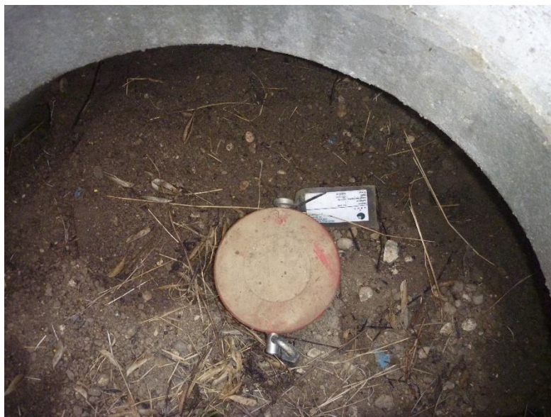
Foto 1: Forerøret i GKB18B var noget kort. Boringen overholdt dog ved tilsynet gældende krav i bekendtgørelse nr. 1260 af den 28. oktober 2013 om udførelse og sløjfning af boringer og brønde på land.
