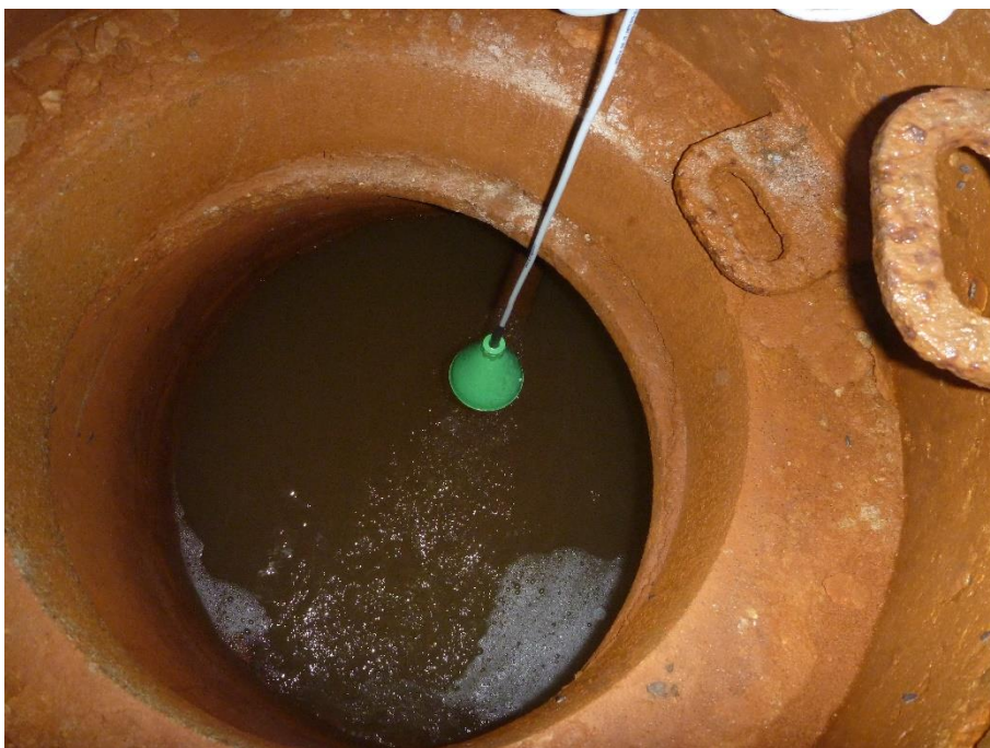
Foto 3: Flow i perkolatet i pumpebrønden.
