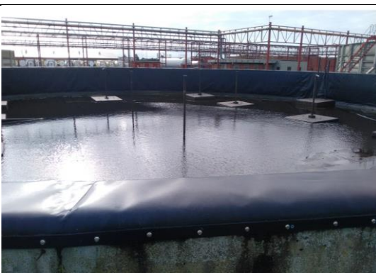
Billede 7. Beholder til slukningsvand.
