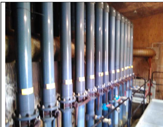
Billede 6. Manifold til styring af overfladevand.
