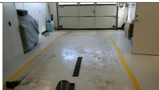
Billede nr. 10: Gulv afløb ved ambulancen
