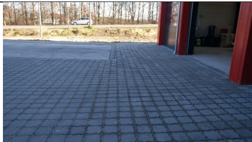
Billede nr. 7: Hældning fra bygningen ned mod vaskepladsen
