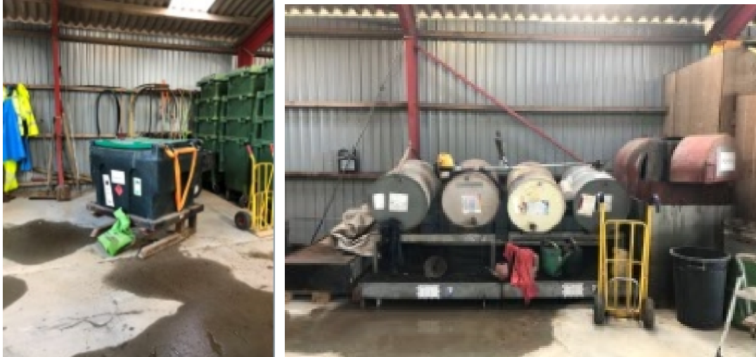
Foto 31-32: Maskinhal – Transportabel dieseltank og oplag af olier og kemikalier.
