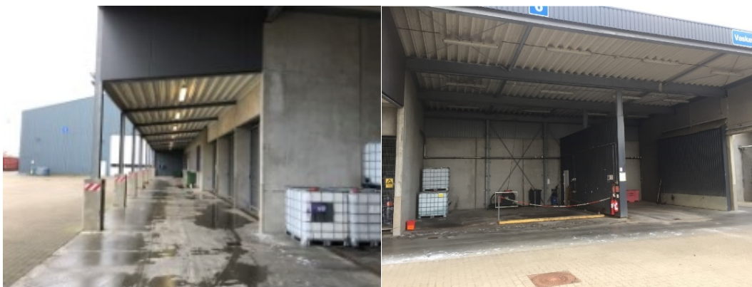
Foto 17-18: Overdækning foran tømningsplads (i forlængelse af aflæsseplads for hal 6) samt tømningsplads set forfra.
