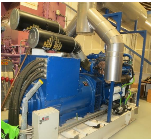
Til venstre; nødstrømsanlæg med integreret olietank. Påfyldes fra den udendørs tank T1. Til højre; afkast fra nødstrømsanlæg, skønsomt i 15 m højde, men ikke over tag.
