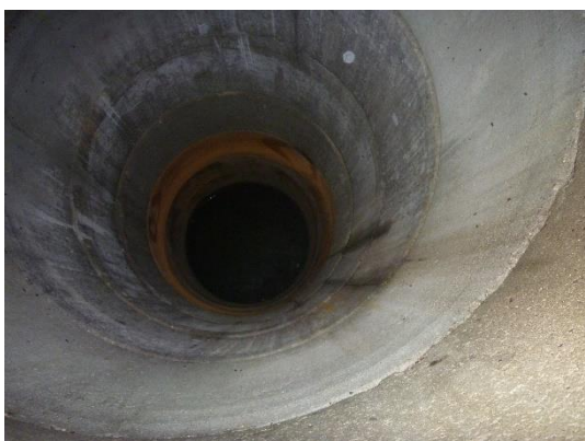
Figur 6: Det indre af Brønd 1 Syd. Der ses perkolat i bunden.
