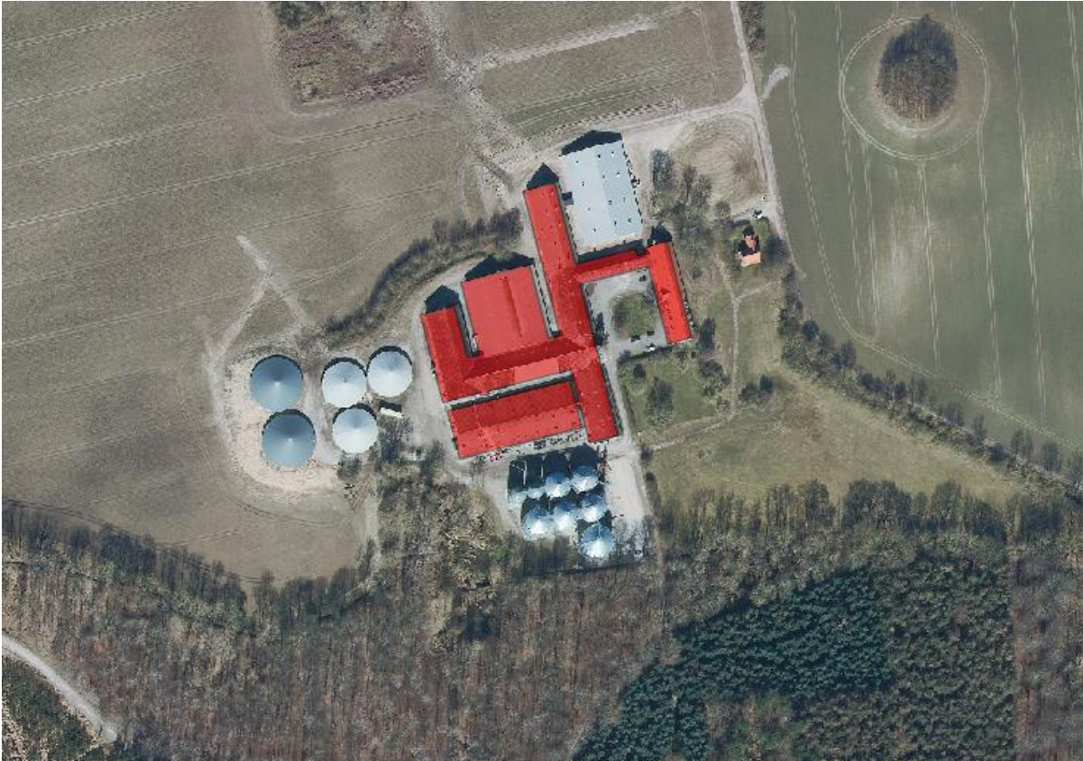
Oversigtskort, luftfoto 2021: Ny klimastald er etableret, og 2 nye gyllebeholdere er etableret.
