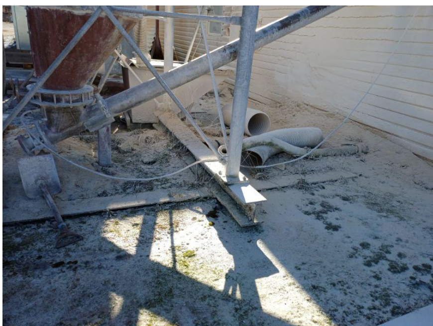
Spild af kalk fra lækket rør ved indføring af kalksilo
