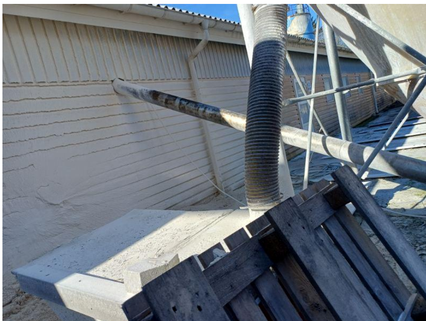
Spild af kalk fra lækket rør ved indføring af kalksilo
