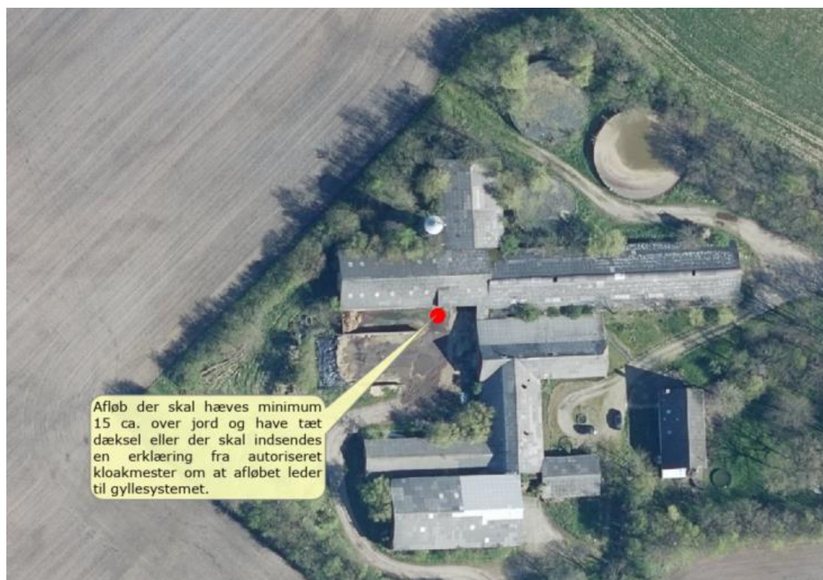
Figur 9 Afløb der enten fører til tidligere tagvandssystem eller til gyllesystemet
