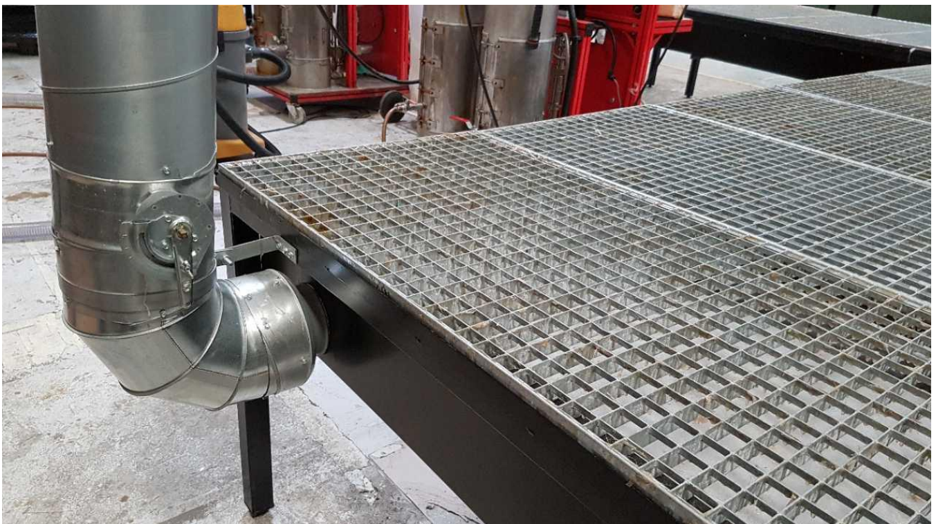
Undersøg ved støbebordene.
