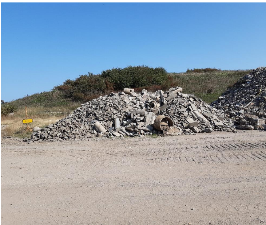
Ovenfor og på næste side ses oplag af bygge- og anlægsaffald.
