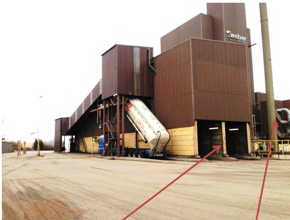
Figur 9 Læssegade, portåbning (16) i baggrund ses skorsten og ventilator (07 og 08)
