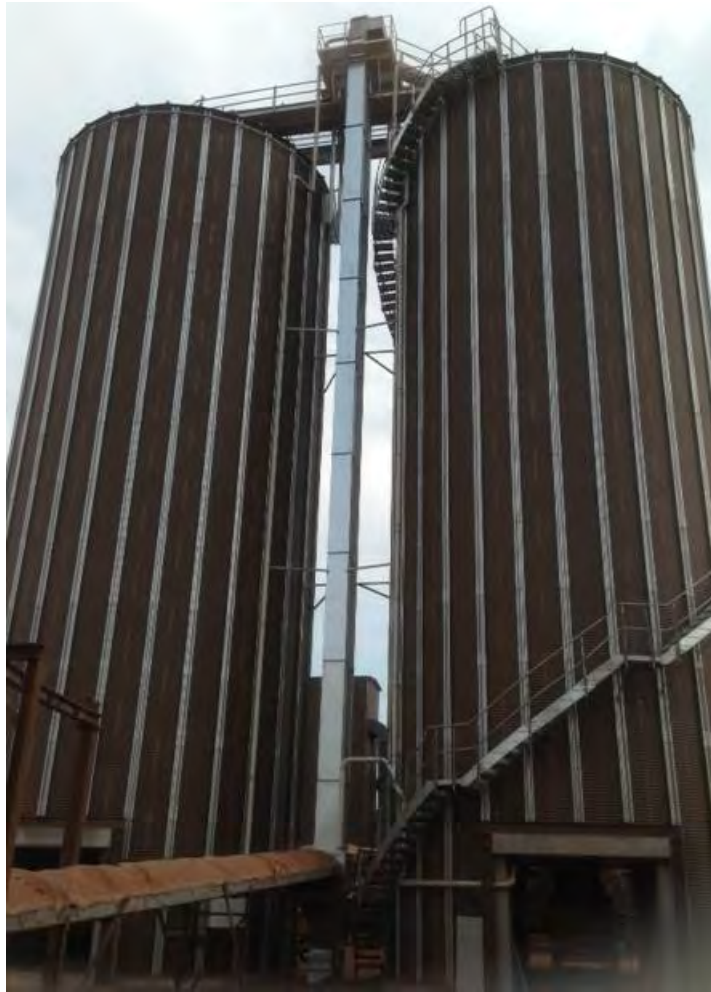
Figur 12 elevator og elevatortop (22 og 23)
