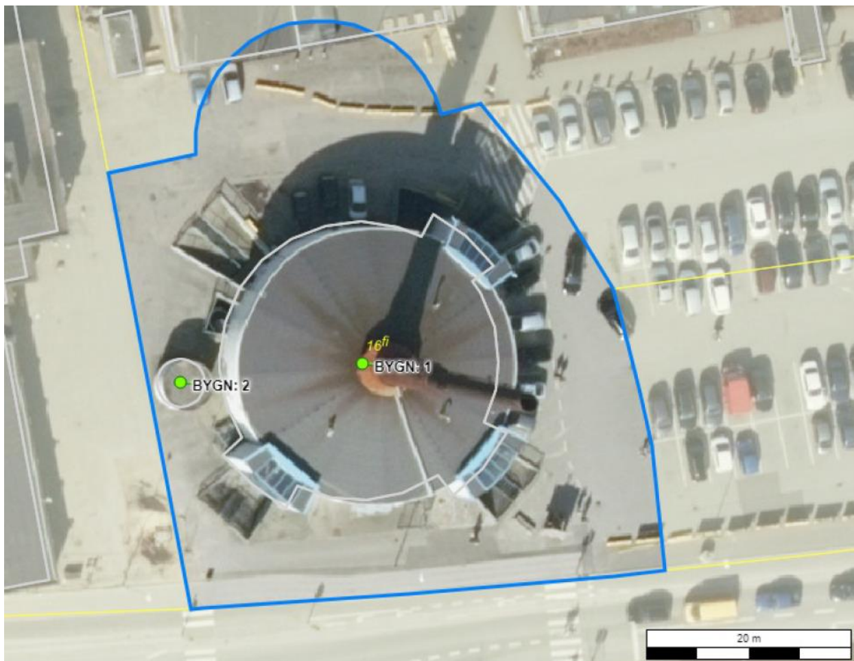
Luftfoto af varmegærsbygningen med matrikelskel
