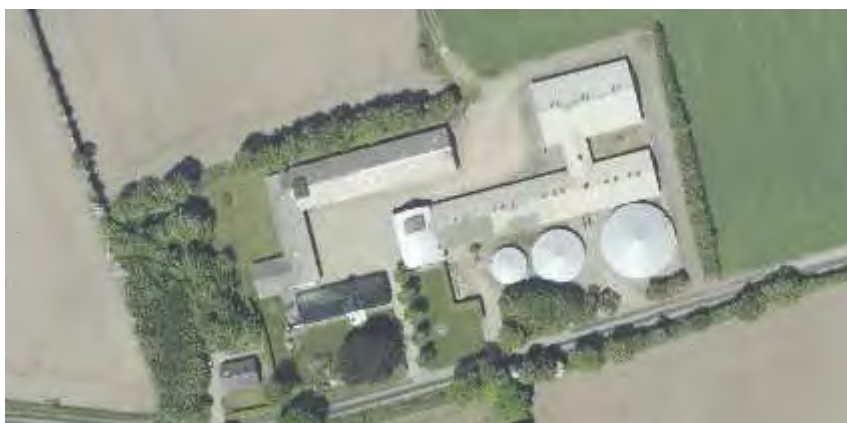
Figur 3. Skråfoto af ejendommen.
