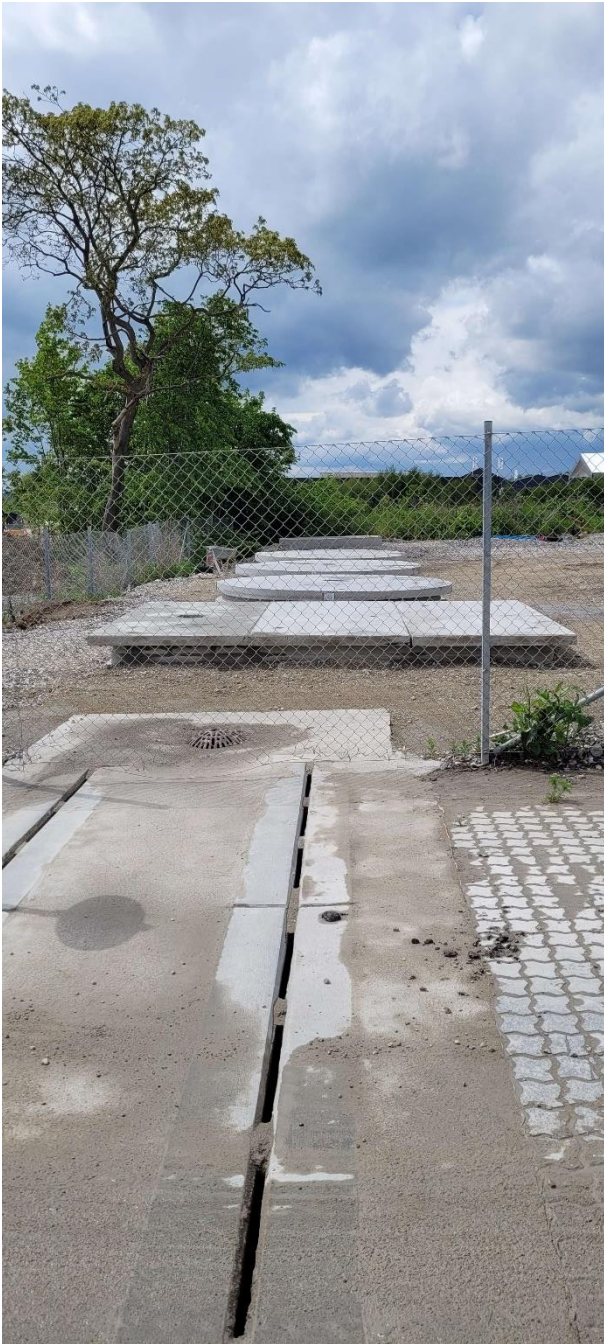
Overfladevand opsamles via afløbsrende og ledes til tanke, som ses bagved. Vandet benyttes til produktionen.
