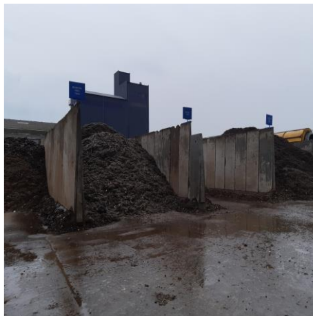
Båse i det udvidede areal bag kold SIS-hal - Fuelbunken højere end beton-elementer
