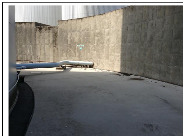
Belægningen i lille tankgård
