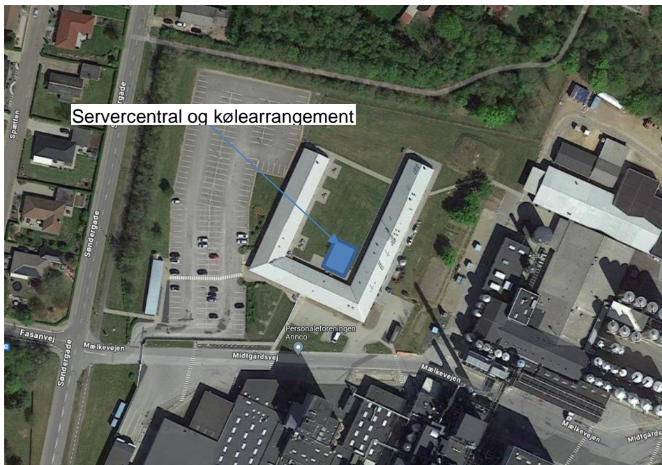
Figur 1. Luftfoto med placering af servercentral og kølearrangement. Nordvendt ikke i mål.
