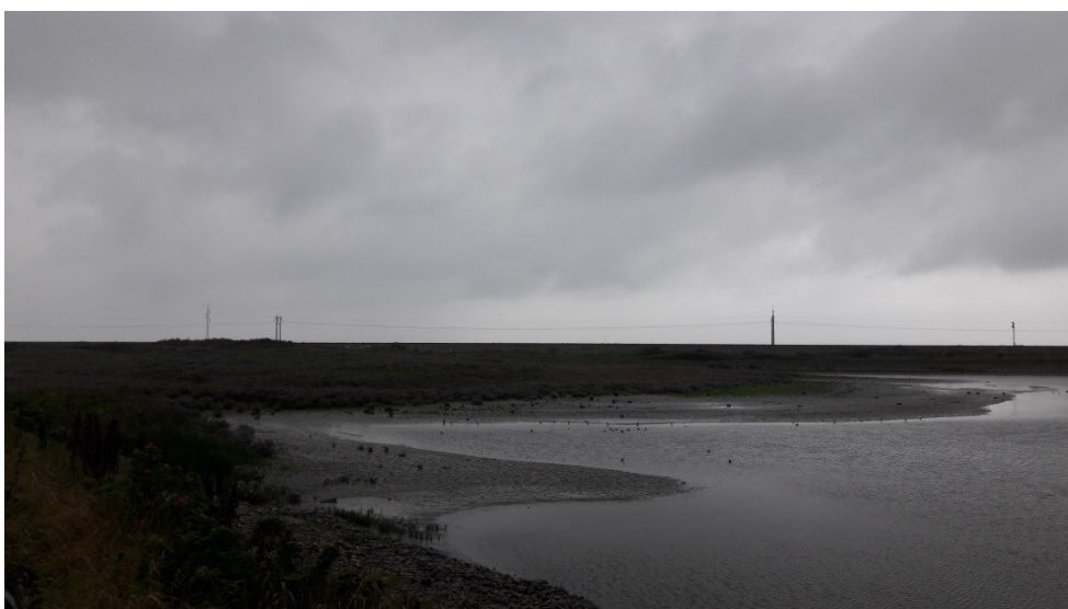
Figur 3. Deponeret sediment i det syd-østlige hjørne af deponiet.
