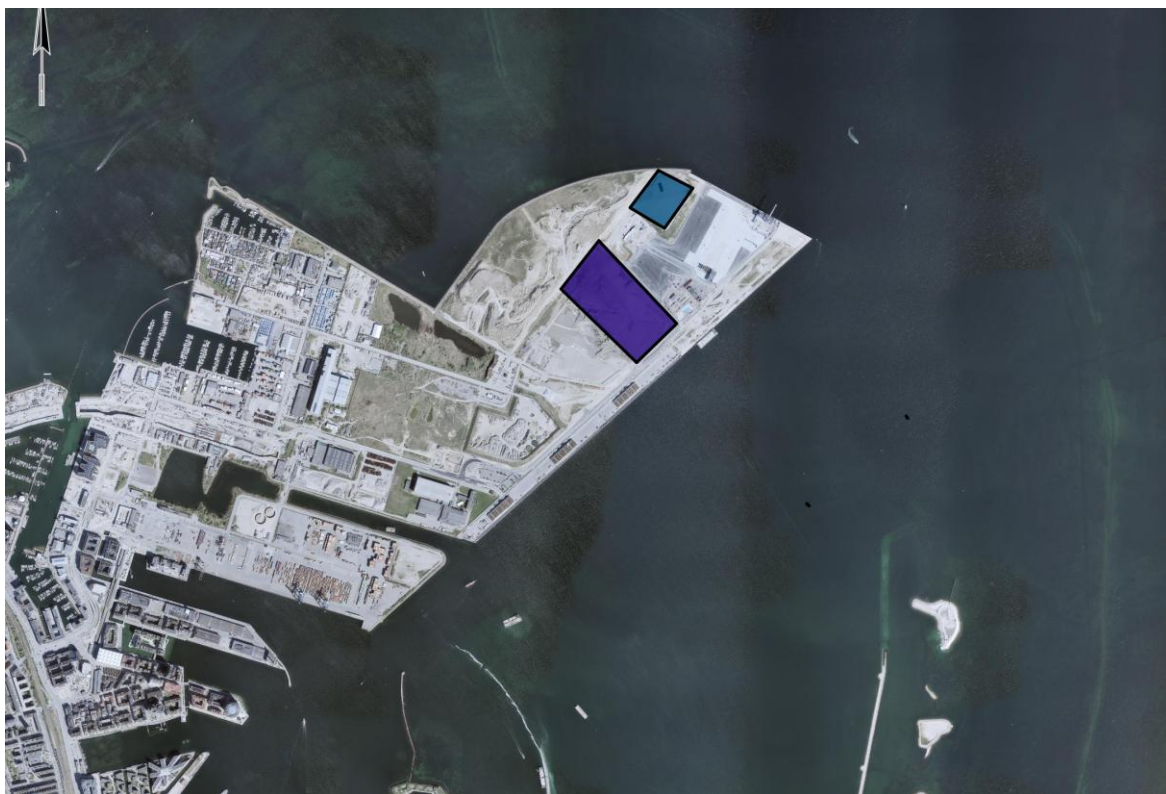
Figur 1. KMC Nordhavnsdepotet, markerede arealer er oplag af jord, der skal afskibes til Lynetteholmen.
