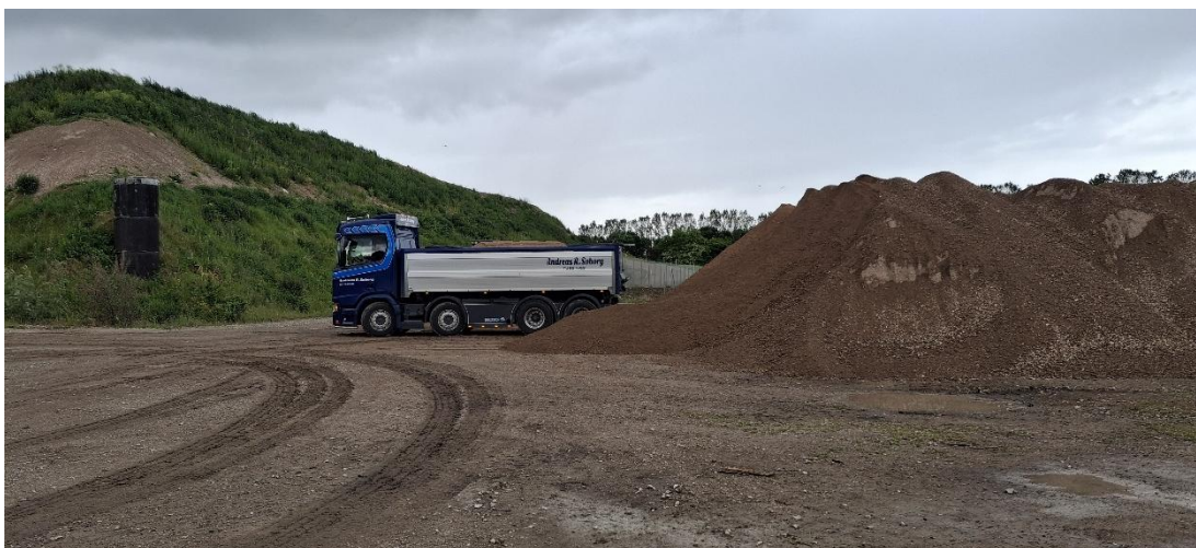
Figur 18. Oplag af ballast til daglig afdækning af asbestholdigt affald.
