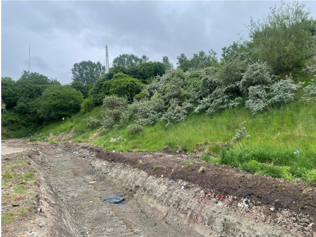
Figur 23. Etablerede enheder er skredet og overskrider barrierer, her deponeringsenhed 4.
