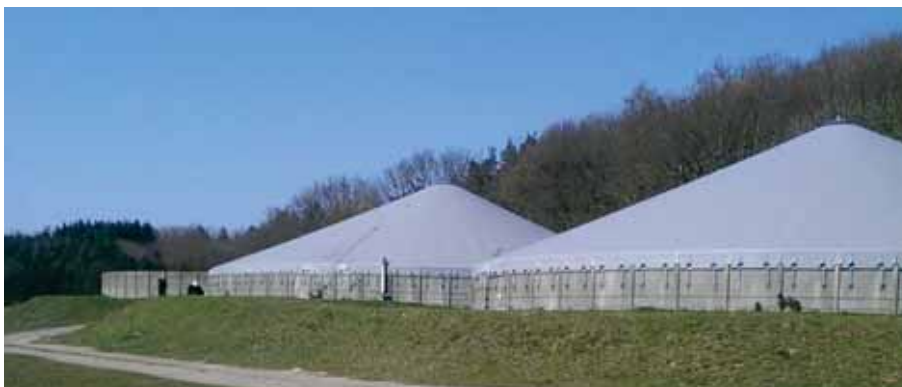
Foto 3. De tre gyllebeholdere - to med og en uden teltoverdækning
