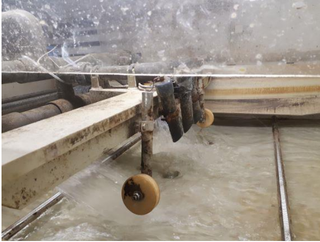
Rent vand efter fældningstank til filterdug.
