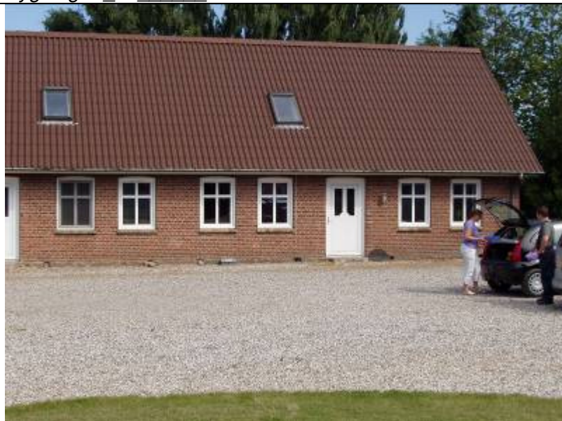
Bygning nr_19 Anvendelse: Stuehus
