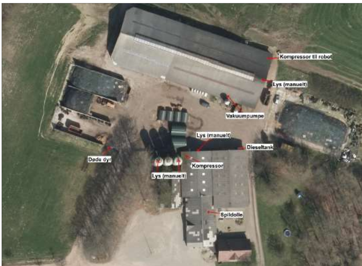
Figur 7. Oversigt over husdyrbrugets installationer og indretning.
