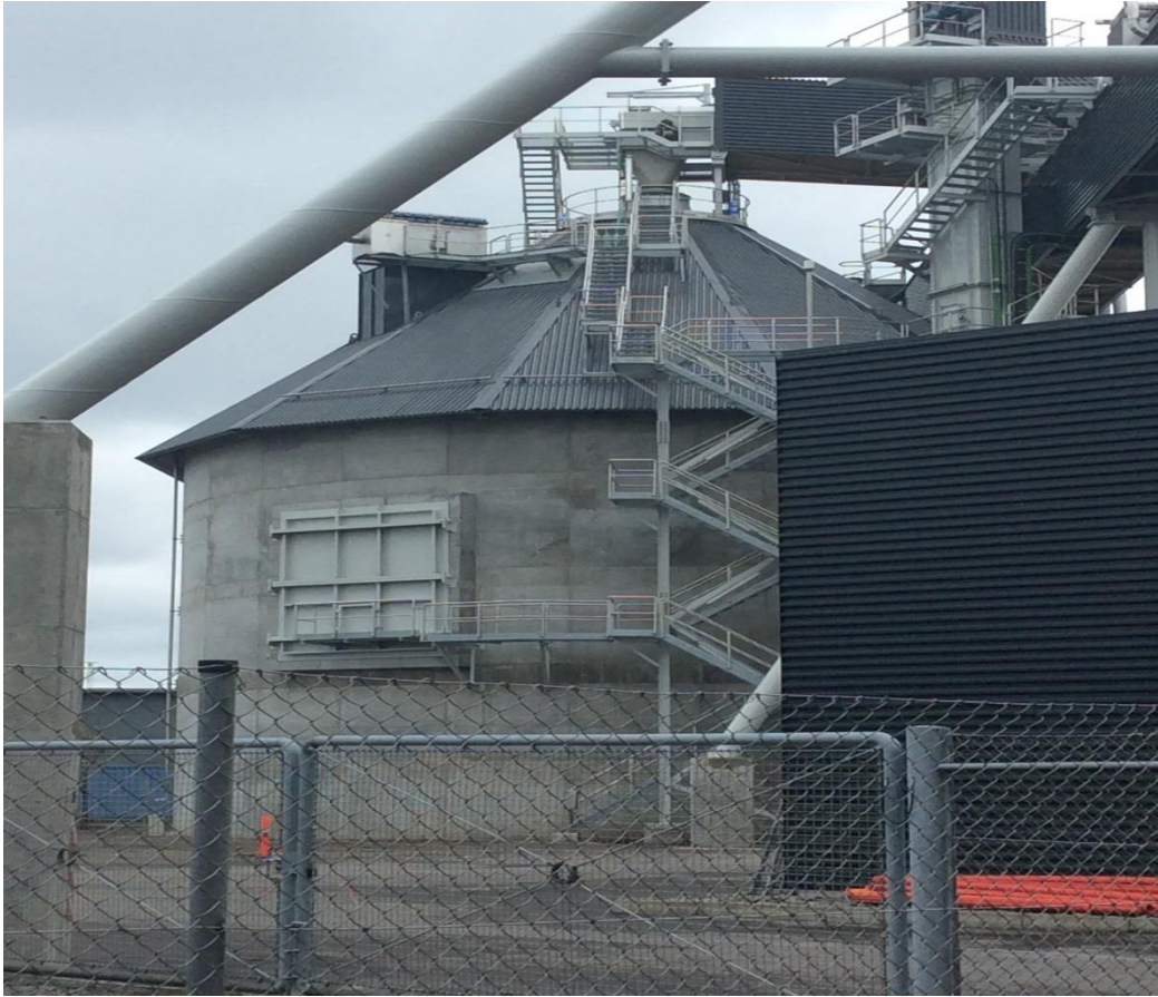
Foto 3: Nyopført 3.000 m 3 flissilo
