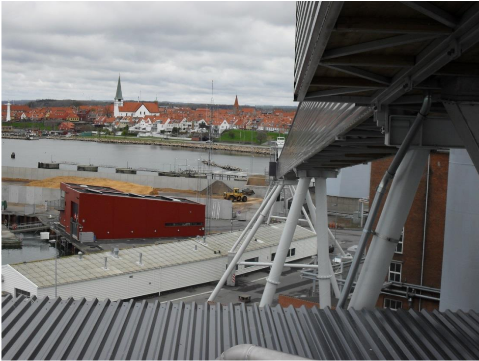
Foto 1: Oplagsplads og nyetableret lukket flistransportør.
