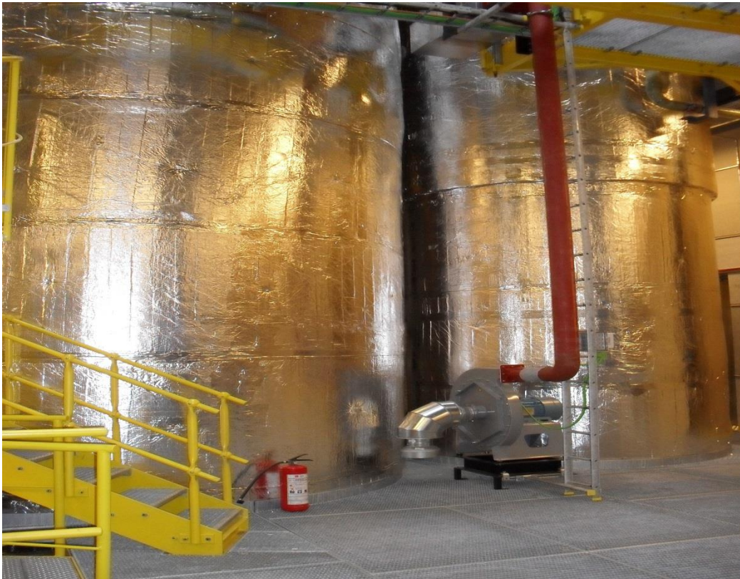
Foto 4: Røggaskondenseringsanlæg
