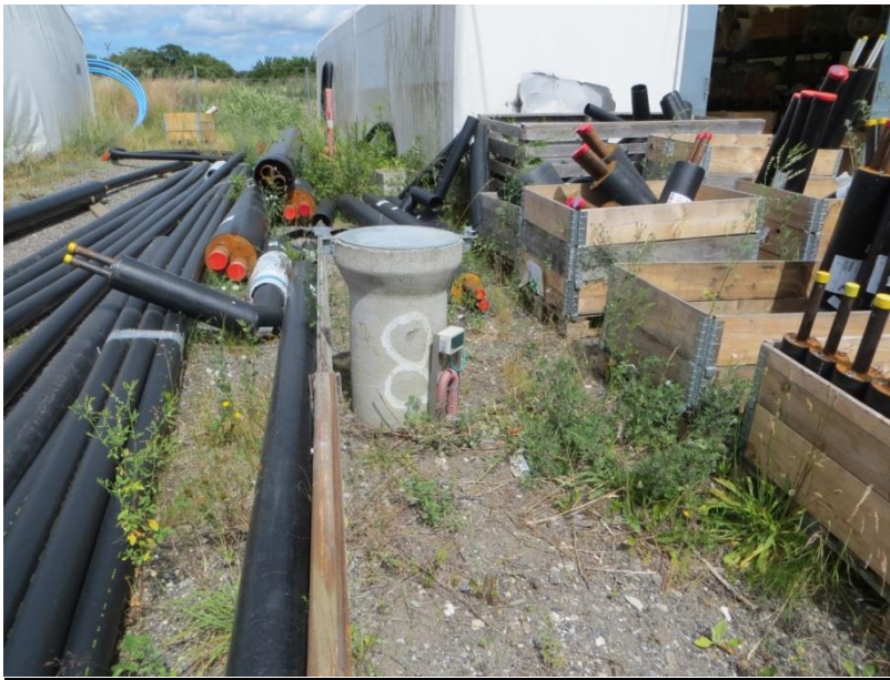
P8 Kontrolboring med transmitter ved varmeværk.
