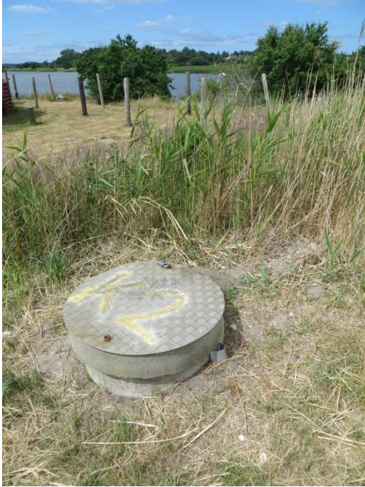
K2 ligger meget kystnært, den er aflåst og tydeligt mærket med borings nr.
