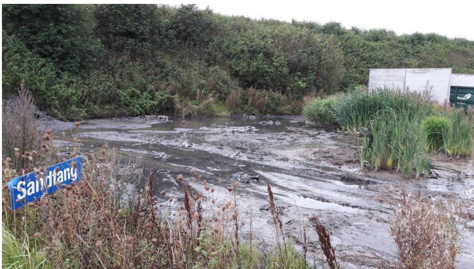
C Bassin til modtagelse af sand fra sandfang. Udløbsrør ses midt i billedet.
