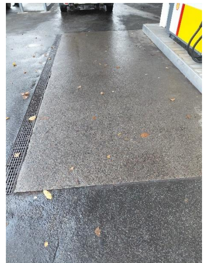
Belægning ved tankningspladser foran butikken
