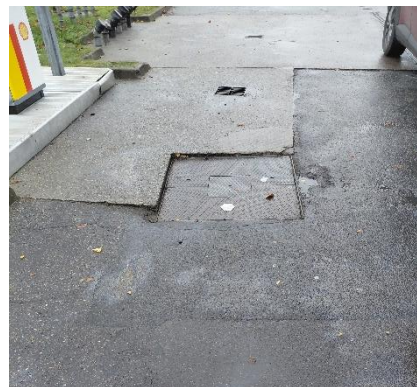
Belægning ved benzinstander mod Hornbækvej
