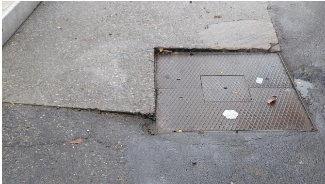
Belægning ved benzinstander mod Hornbækvej
