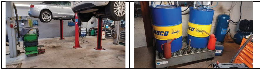
Værksted indrettet med 2 lifte. Eksempel på spildbakke.
