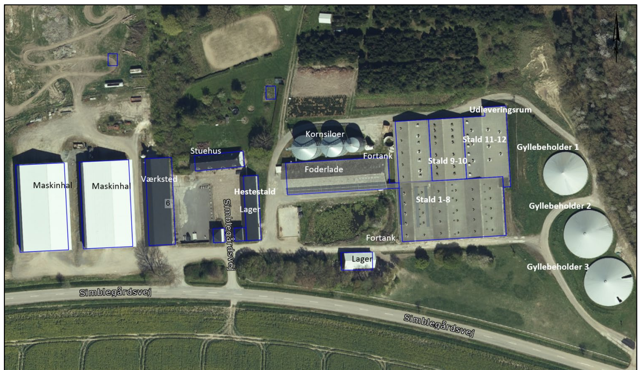
Figur 5 Anlægget på Simblegård
