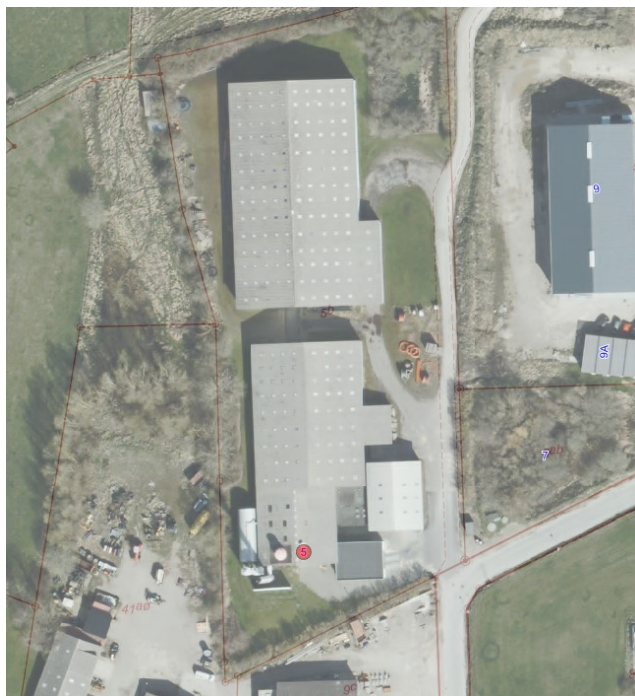
Luftfoto af Tranbjerg Varmeværk
