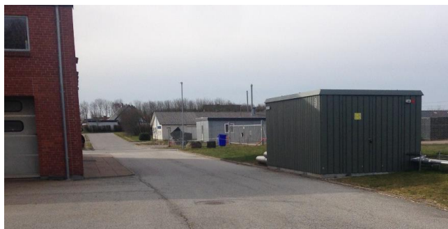
Tilbygning med varmepumpe
