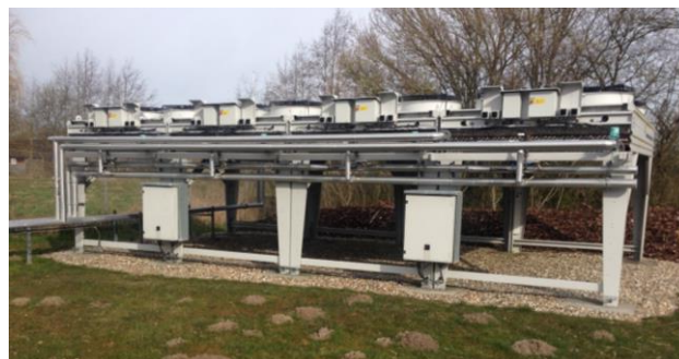
Luftfang til varmepumpe
