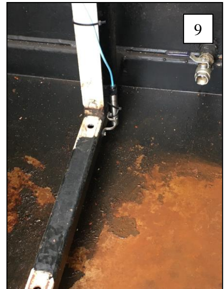
Foto 9 af føler for overfyldning i bunden af tankskur.
