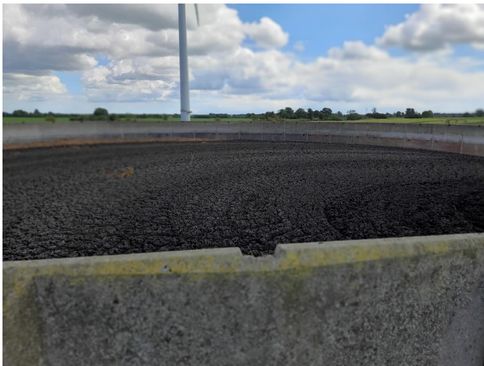
Uoverdækket slam i beholderen
