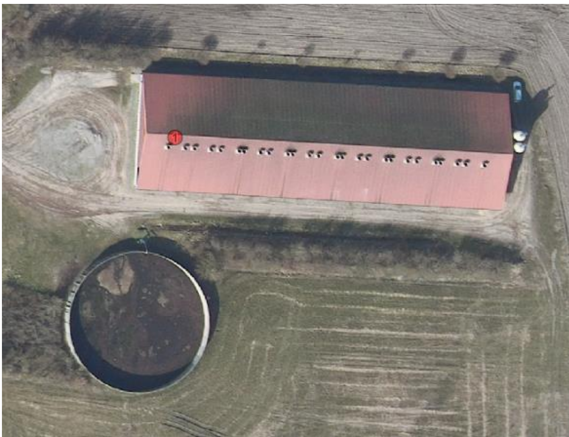
Figur 1. Oversigt over bygninger.
