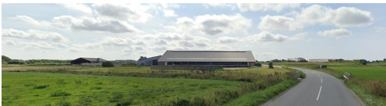
Figur 6.4.1. Foto af driftsbygningerne set fra den nordlige side. I forgrunden ses gyllebeholderen, bagved denne ligger den nordlige stald 1. Til venstre ses halmladen. Foto fra maps.google.com.
