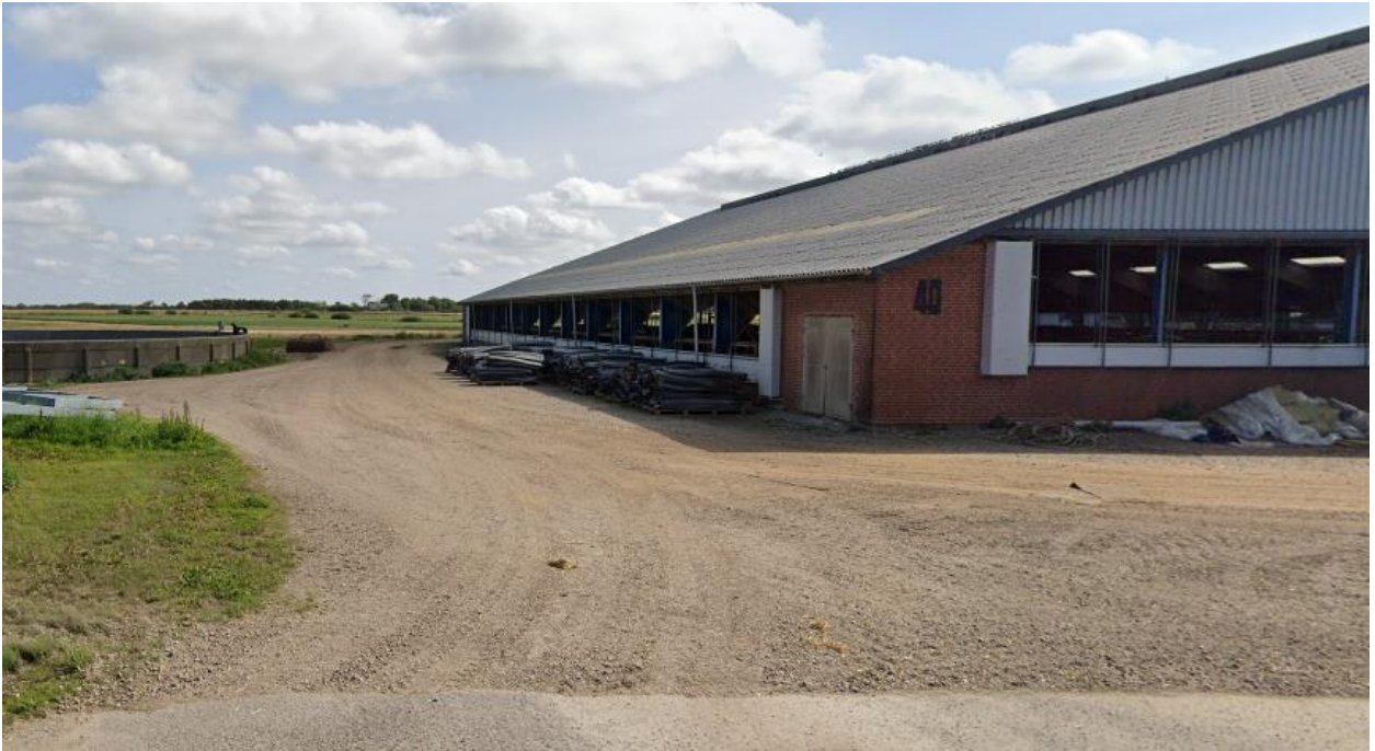
Figur 6.4.2. Foto af gyllebeholder og stald 1 set fra Kvongvej. Tilbygningen bliver placeret til venstre for stalden i umiddelbar forlængelse af denne. Foto fra maps.google.com.
