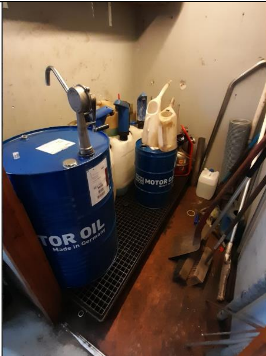
Dunke opbevares på stativ med spildbakke på betongulv.
