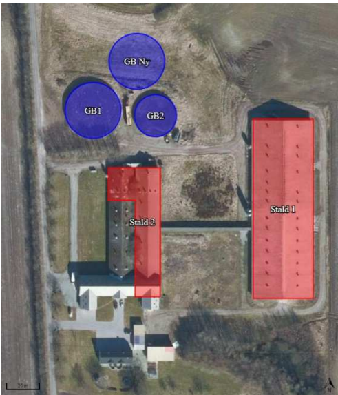
Figur 1 Placering af stalde på Brasholtvej 180
