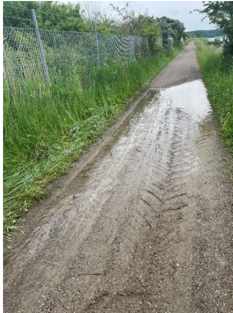
Synlig påvirkning af sti ved afsnit 2 (som ikke var der på tilsyn 29/5)
