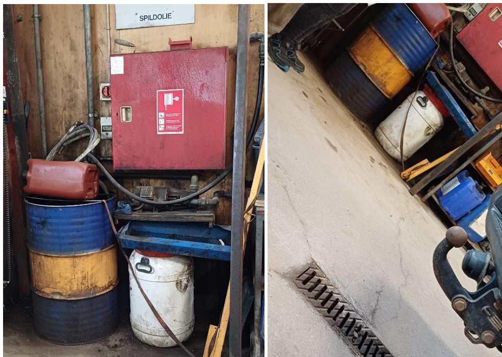
Figur 2 Tønde til spildolie (venstre) og afløb til olieudskiller (højre)
